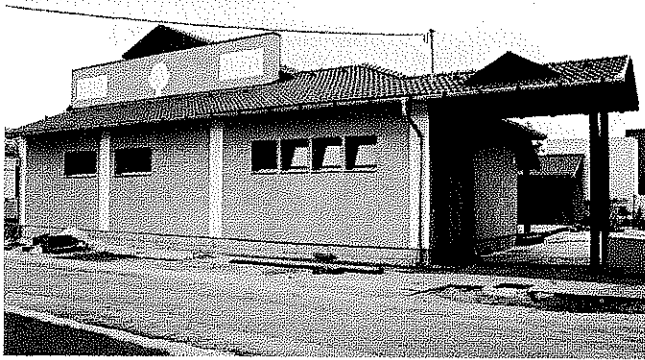
Tornaterem a műszaki átadás előtt
