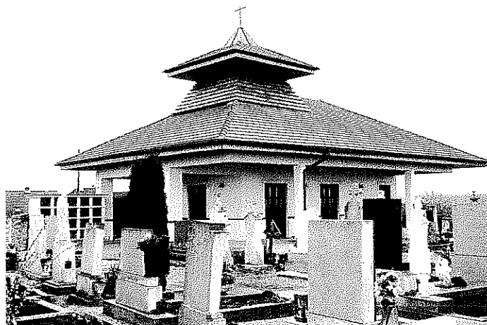
Elkészült a ravatalozó felújítása
